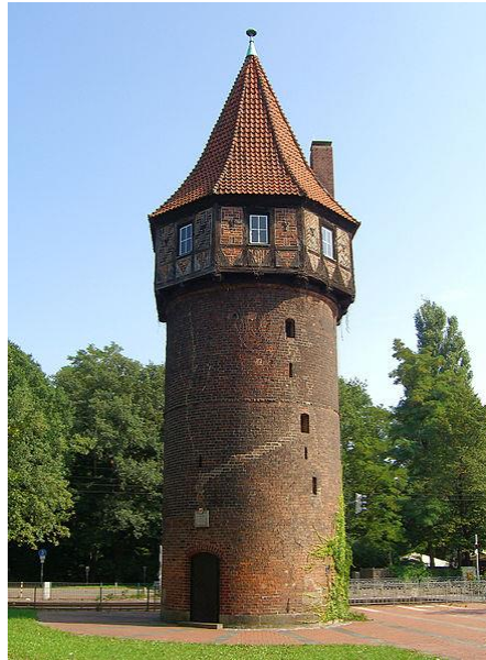
Döhrener Turm in Hannover
